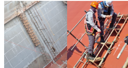
LNG HOPPER JOINT부 용접 작업 추락 개선
