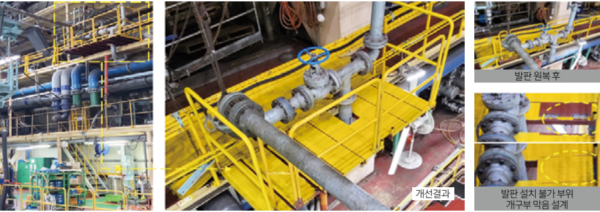
대형엔진시운전3부 Starting Air 설비 배관 설치부 안전 작업공간 확보 외 떨어짐 개선(장려상)
