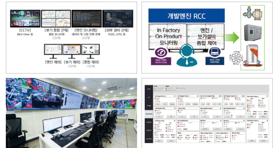
개발엔진 공장 자동화(원격 모니터링, 원격 제어, 통합(자동)제어, 관제실, F.O Pump 판넬 원격 제어
