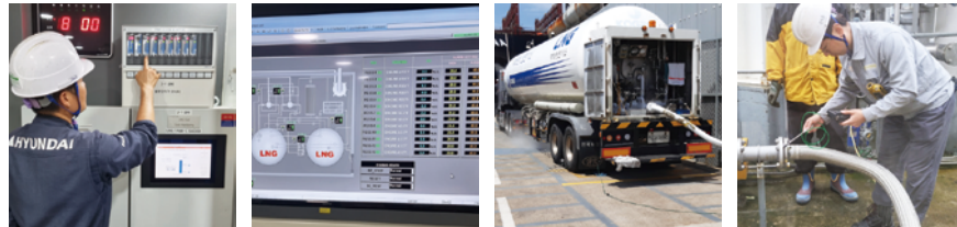
엔진1지역 가스 공급설비 화염감지기 및 소방 살수장치 작동점검, 가스 벙커링 화재/폭발 점검
