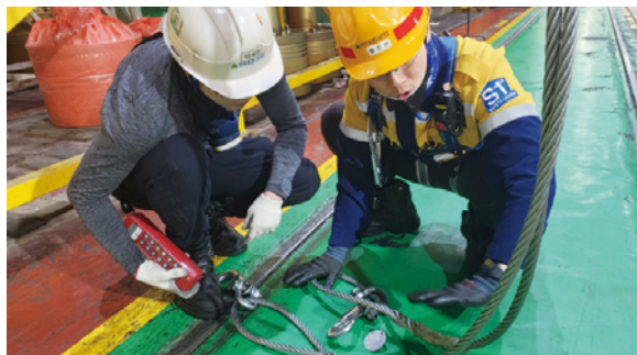
엔진기계안전부 슬링·와이어로프·벨트 점검, 주간점검 캘린더
