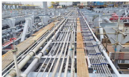
Unit 상부 통행용 발판 및 안전고리 체결용 자일로프 설치
