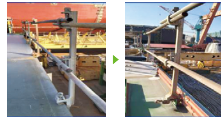
블록 탑재 간섭 안전시설물(난간) 설치 개선
